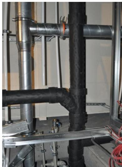
**El sistema multicapa K-Flex K-Fonik ST/GK proporciona una excelente barrera acústica, a la vez que se utilizan productos libres de plomo y respetuosos con el medioambiente**
