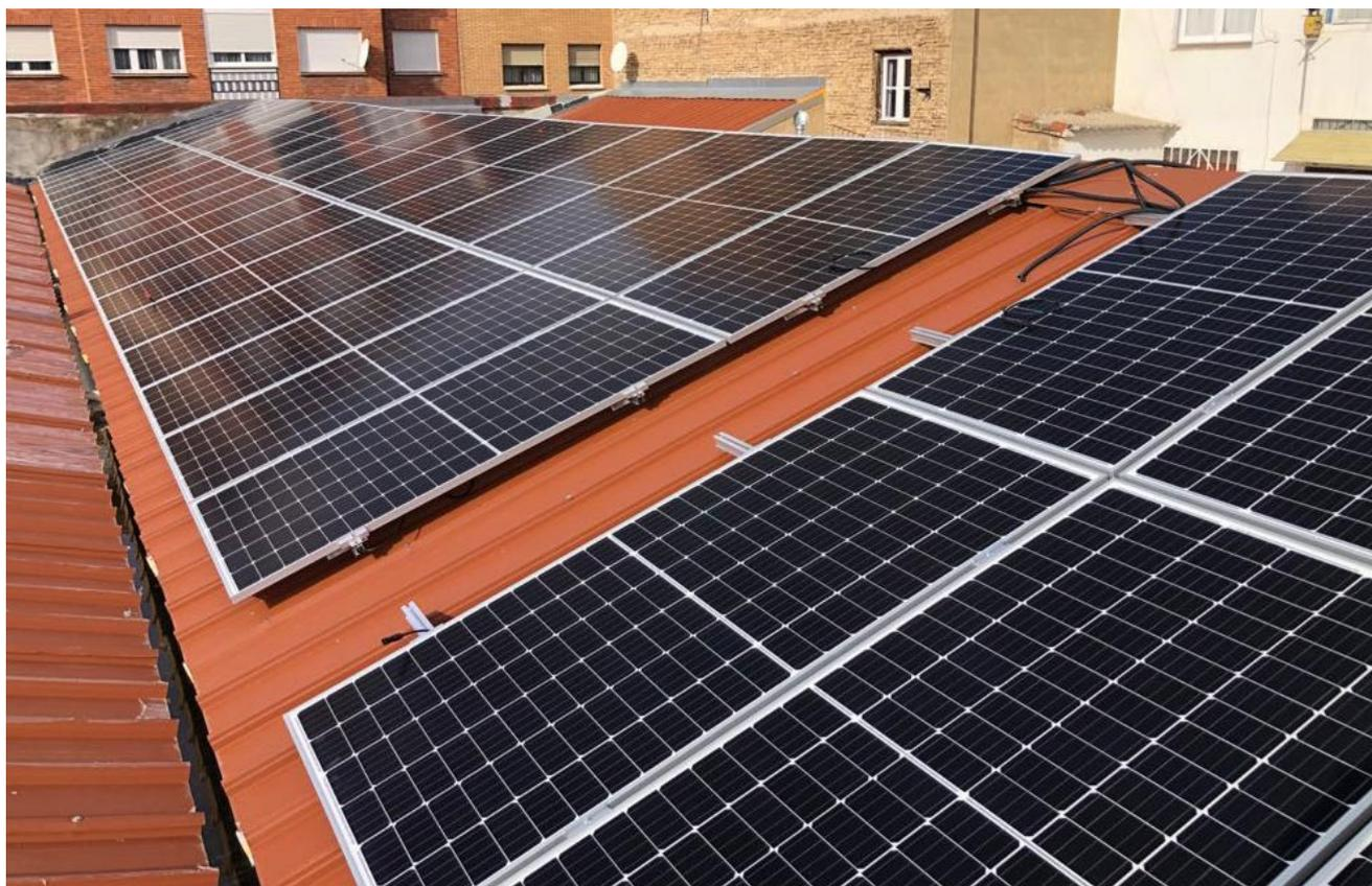
nicos. Por esta razón, son estructuras autoportantes que se fijan en la propia cubierta en los casos en que la resistencia mecánica a la tracción y compresión de la cubierta esté garantizada. En caso contrario, se sitúan sobre las vigas transversales (correas) o elementos de suportación de la cubierta, afianzando así la estructura a un elemento seguro del edificio.
