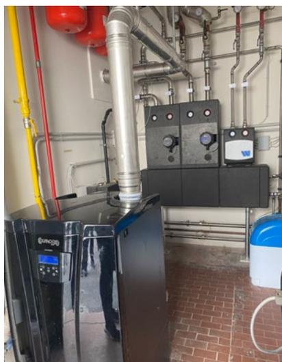
La **Serie PASM** puede ajustar la temperatura de entrada del fluido en el circuito secundario de acuerdo con una señal externa. Para esto está equipada con una válvula mezcladora de tres vías accionada por un actuador electrónico modulante de tres puntos. Este modelo fue instalado en la central térmica con regulación climática donde la temperatura de entrada del circuito secundario se modula de forma continua según los parámetros del sistema.
